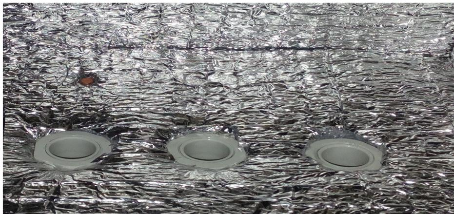
Фото 7 — Расположение сальников для подключения питания терминала
